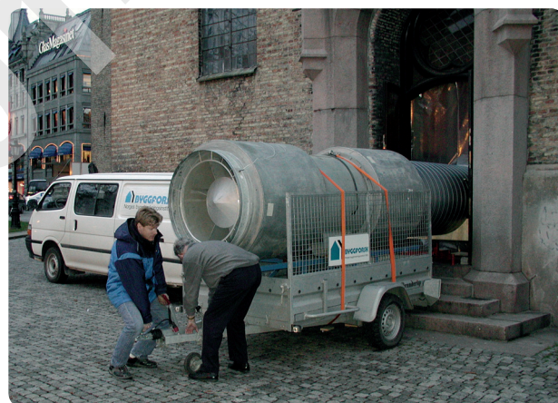
Fig. 222 b Vifte til måling av lufttetthet i store bygninger. Foto: SINTEF Byggforsk
