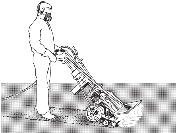
Fig. 33 Fjerning av olje og fett med propanbrenner Ved flammerensning føres «lansen» foran operatøren. Gassflammen brenner bort forurensninger på betonggolvet. Metoden fører til betydelig støvdannelse.
