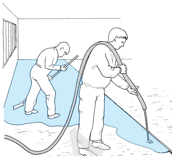
Fig. 74 d Påføring av selvutjevne avrettingsmasse på et stort gulv Gulvet er inndelt i mindre felter med steng. Massen legges ut med slangen og fordeles med nivårake.
